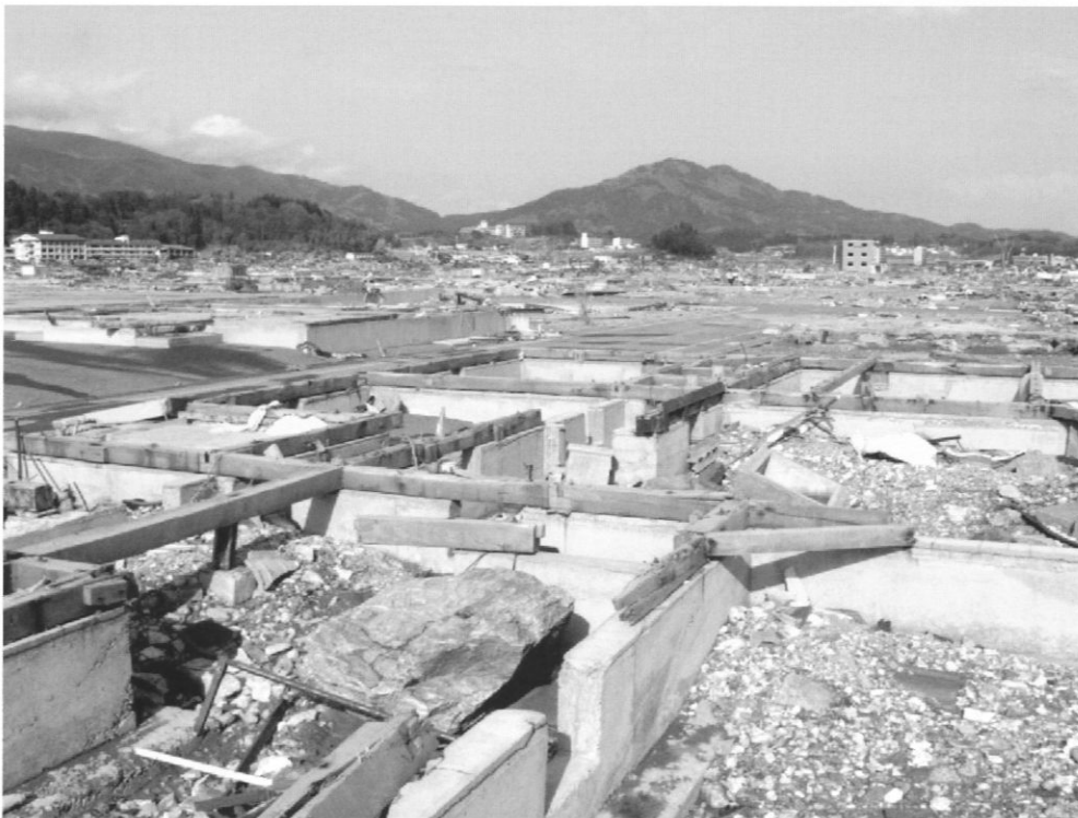
低地では壊滅的な被害を受けた（陸前高田市）
