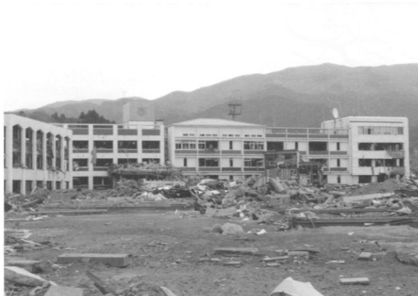
3階まで被災した陸前高田市役所
