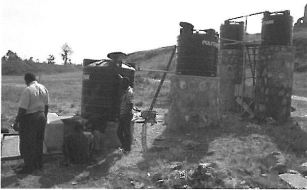
図8 水売り人専用の浄水装置
