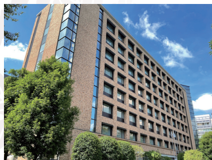
写真1 国立保健医療科学院本館棟 全景
