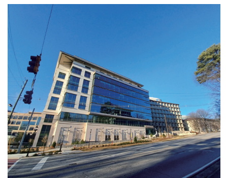
写真2 公衆衛生大学院の校舎(地上8階地下2階建てが3棟)
